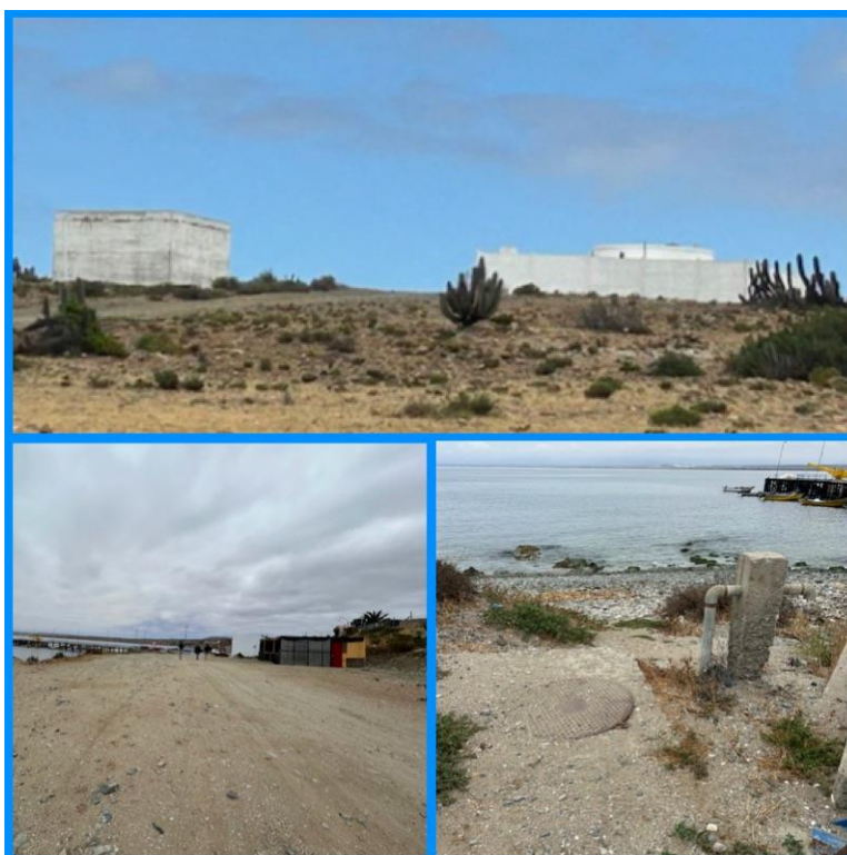
Figura 4: Planta de tratamiento y matriz cercana de agua potable
